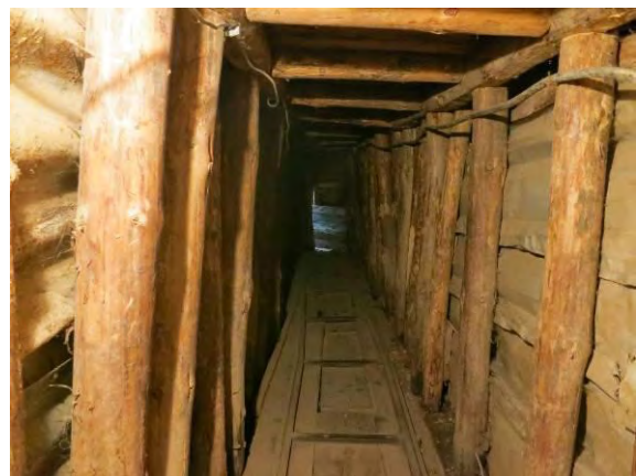
IMG_6620 Der Versorgungstunnel unter dem Flugplatz
