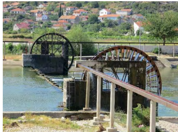
IMG_6407 Bewässerungsanlage in Trebinje
