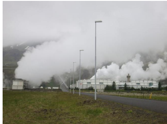
Das geothermische Kraftwerk Nesjavellirvirkjun
