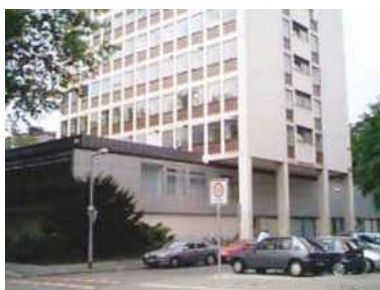
Das Gebäude der Süddeutschen Zucker am ehemaligen Standort des Wohnhauses an der Maximilianstrasse in Mannheim
